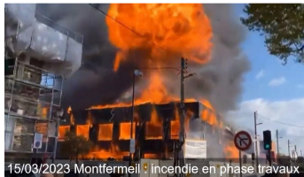
15/03/2023 Montfermeil : incendie en phase travaux
