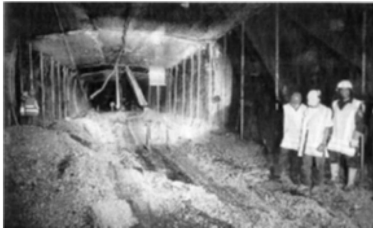
Fig 5 : Vue des dommages causés par l'incendie dans le tunnel de Tauern.
