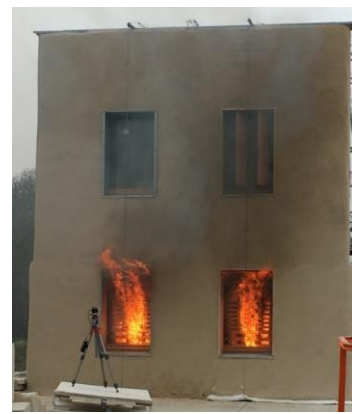
Vue de la façade à t = 1 min
