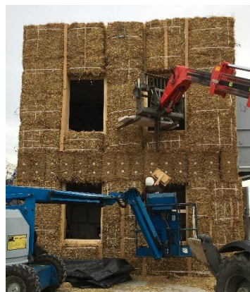
Montage de la façade
