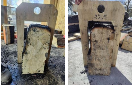
Poutre Nord-Est Poutre Nord-Ouest
