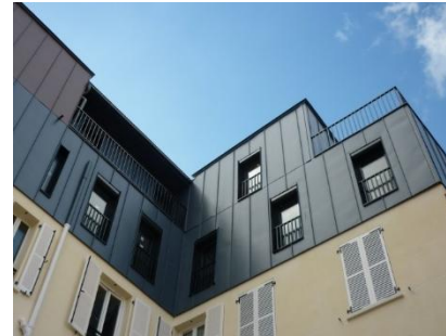
Surélévation ossature bois DTU31.2 sur béton (réhab/neuf)
