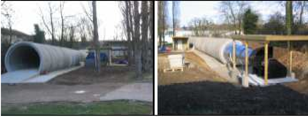
Figure 1 - Vue d'ensemble de la galerie
