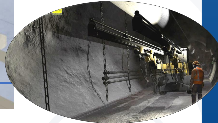
Galerie en travaux (500 m)
